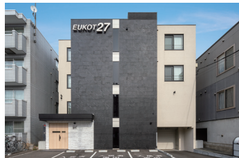
21年に新設した本社屋
